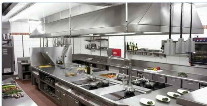
整体厨房工程项目现场
