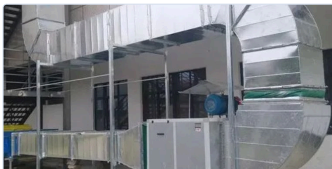
通风管道工程·油烟净化配套
